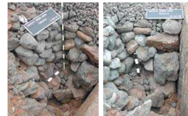
Trinchera excavada detrás del muro: reforzamiento del relleno mediante muro de rocas seleccionadas por tamaño, fundación con apoyo de cadena de concreto, y nuevo relleno superficial con grava (kikiri).
