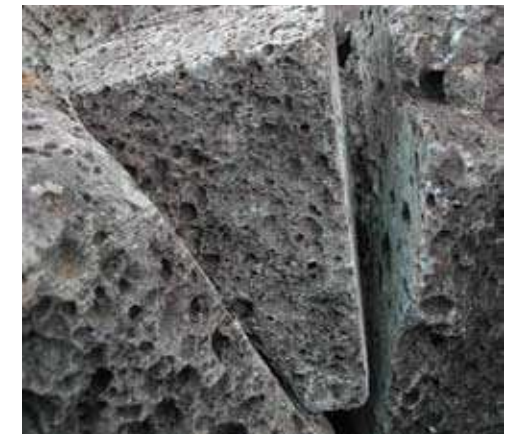
Extremo noreste: bloques cortados con disco para completar secciones faltantes del muro frontal.
