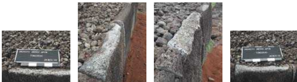
Las superficies alisadas por el disco fueron martilladas para recuperar la textura original del basalto vesicular. La pátina oscura se recupera con el tiempo.
