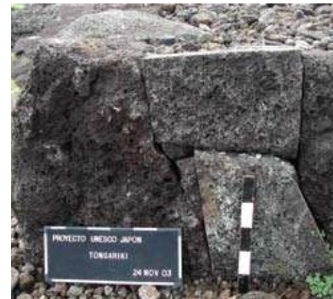
Extremo noreste: bloques cortados con disco para completar secciones faltantes del muro frontal.
