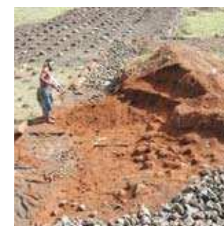
Retiro del relleno de tierra suelta.
