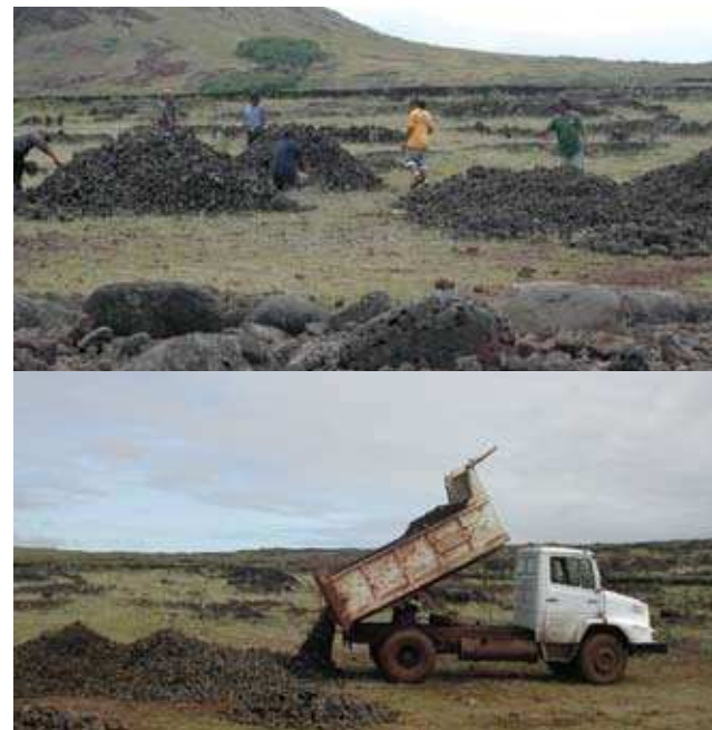
Acopio y selección manual del material para el nuevo relleno.
