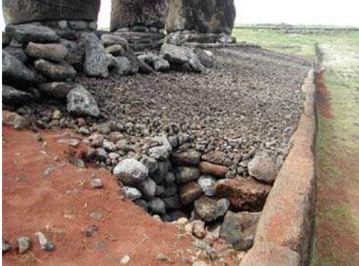
Recuperación de la plataforma superior con kikiri y estabilización del muro frontal.
