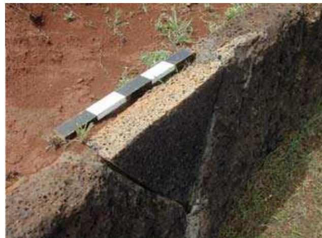
En otros casos, los cortes fueron realizados para nivelar la altura del muro frontal.
